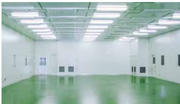
●クリーンルーム内部
